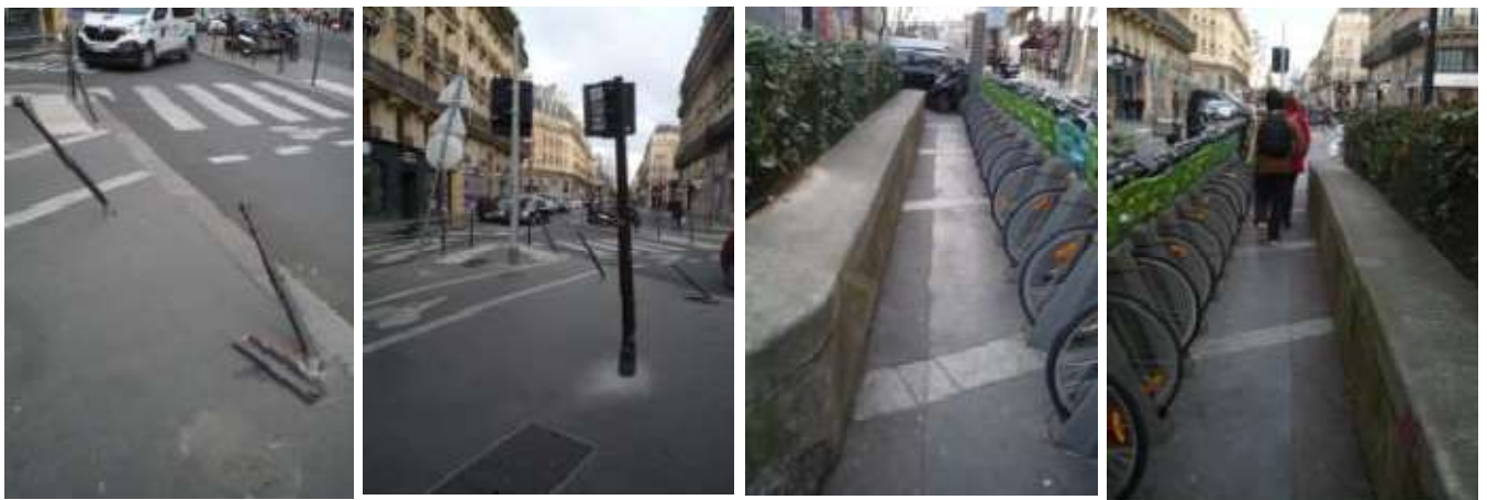
Potelets et mats de signalisation de l'îlot directionnel d'entrée, passage entre jardinière et parc à vélos rue de Turbigo
