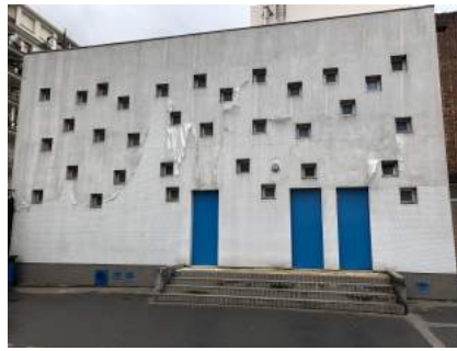
Façade côté collège
