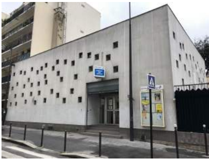
Façade côté rue de Amiraux
