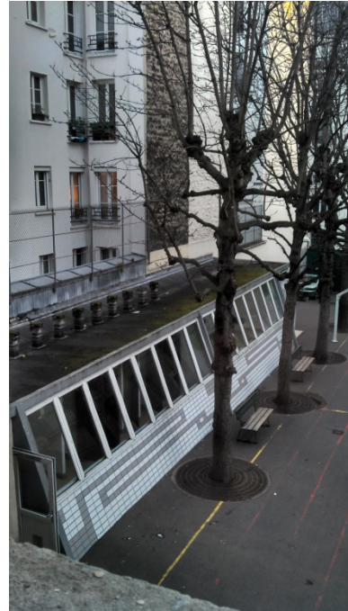
Vue du toit des toilettes en l'état actuel
